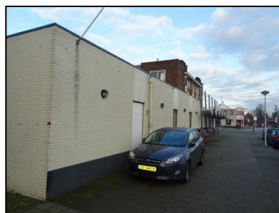
Figuur 4. Oostzijde van de onderzoekslocatie.
