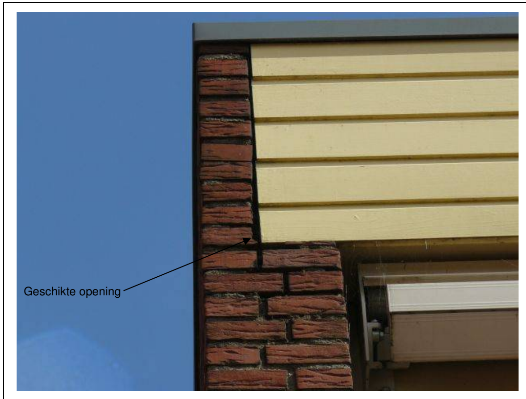
Foto 1. Geschikte openingen kunnen voor vleermuizen toegang verlenen tot de spouwmuren.
