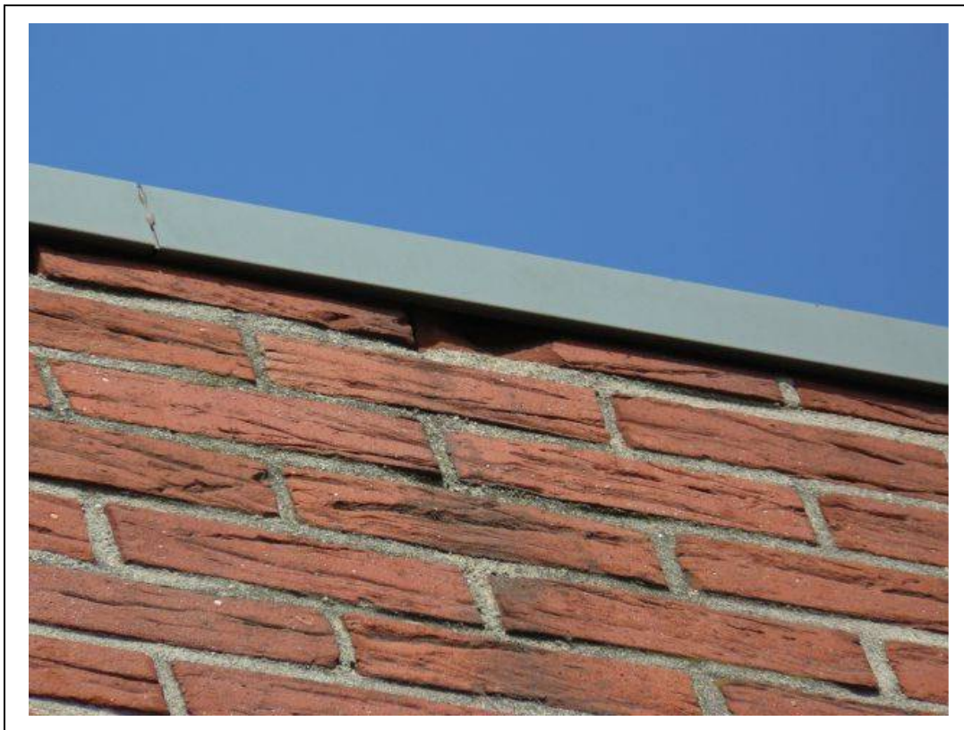
Foto 2. Ook zijn ruimtes achter betimmeringen aangetroffen.
