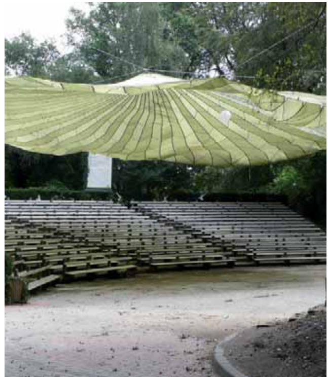
Houten tribunes van het openluchttheater.
