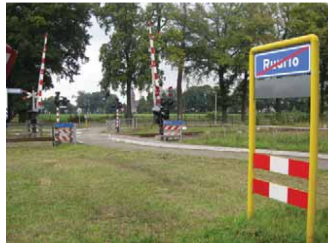
Spoorwegovergang bij Ruurlo.
