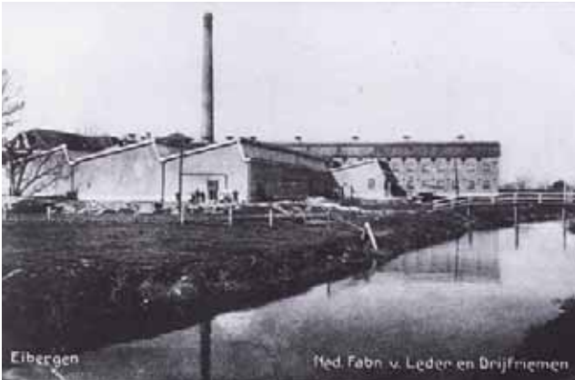
De Prakte leerfabriek is gesticht op een belangrijke plek: aan de Berkel, waardoor de fabriek voor de scheepvaart bereikbaar was en het water werd ook gebruikt voor het looiproces. 61
