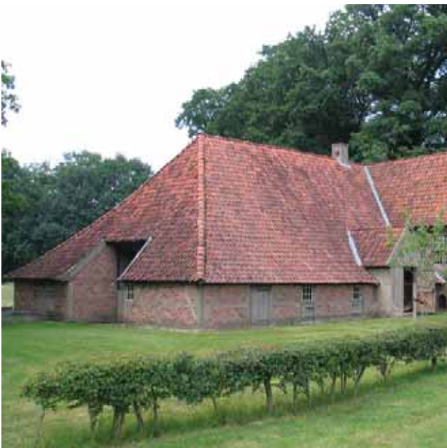
Voorbeeld van een onderschoer bij De Lebbebrugge.
