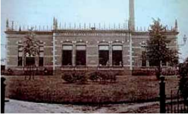
De jamfabriek aan de Stationsweg in Neede.
