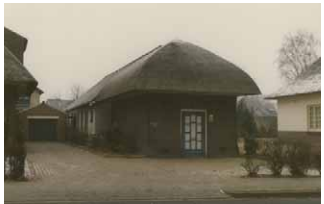
Trafohuisje van de EMB in Borculo.
