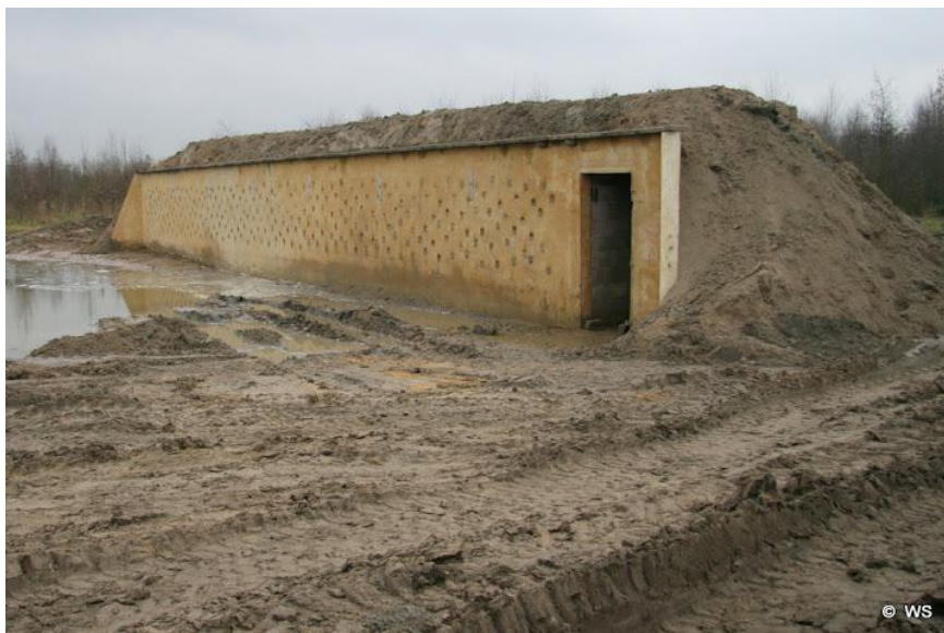
Figuur 4: vleermuiskelder met overwaluwand (Bron: © Willie Smeenk)
