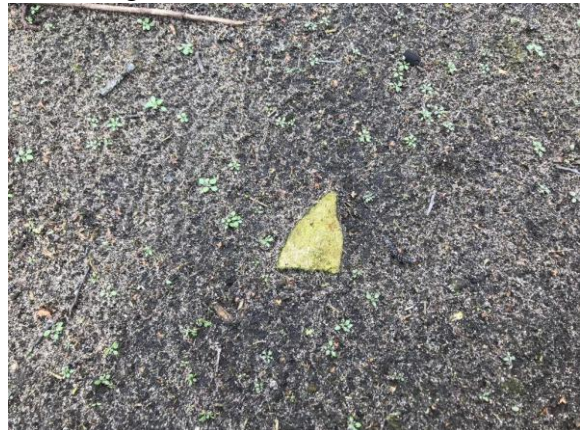
Figuur 4: Asbesthoudend plaatmateriaal
