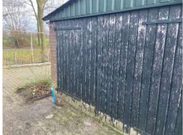
Figuur 14: Locatie bovengrondse dieseltank (inpandig)
