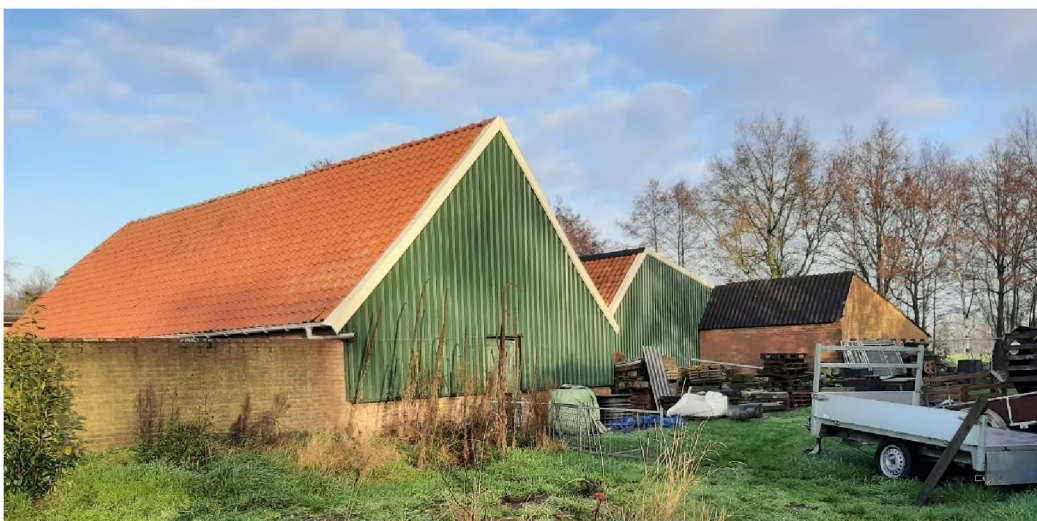
Figuur 14: Foto van de te slopen bebouwing, genomen vanuit het zuidoosten.
