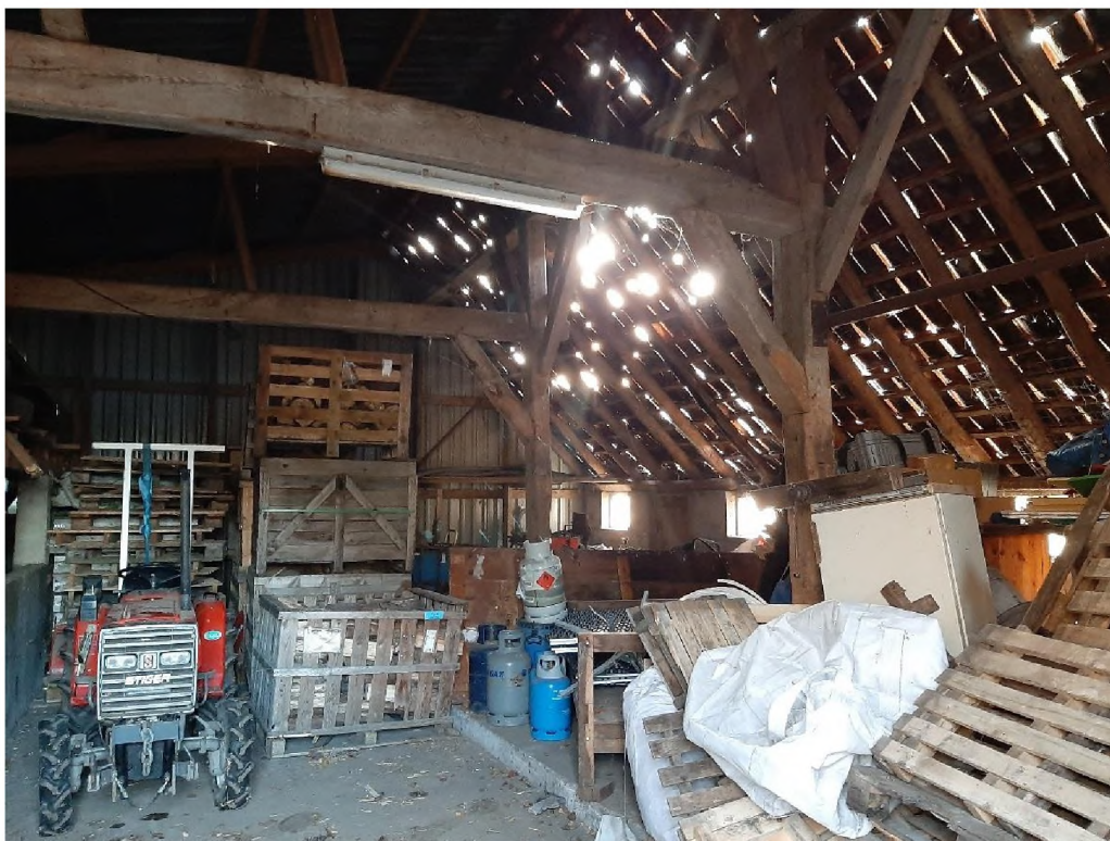
Figuur 17: Foto van de gebinten van de voormalige varker-/runderenschuur waarvan de initiatiefnemer een deel wil behouden als ornament.
