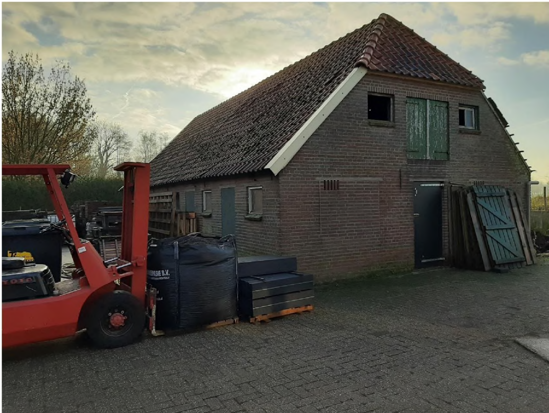
Figuur 15: Foto van de te slopen voormalige varkensschuur genomen vanuit het westen.
