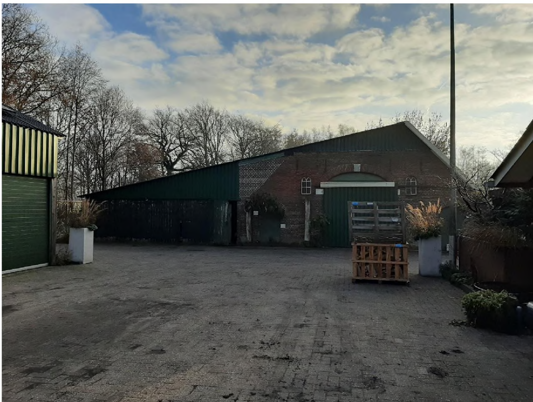
Figuur 16: Foto vanuit het westen van de te slopen voormalige werktuigenberging en varkens/runderenschuur. De initiatiefnemer heeft de wens om historische delen van de voorgevel van dit pand te behouden.
