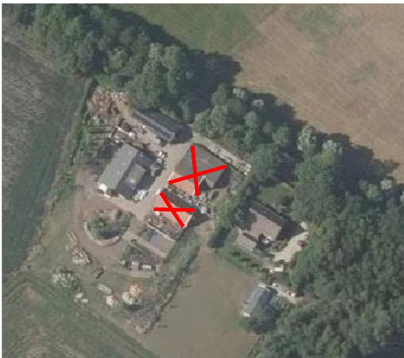
Figuur 7: luchtfoto met daarop aangegeven de te slopen bedrijfsgebouwen
