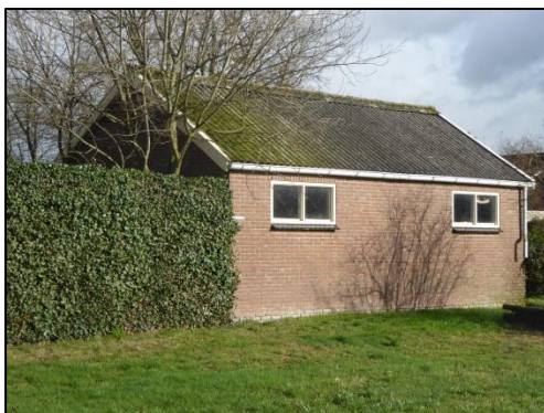
Te slopen schuur.
