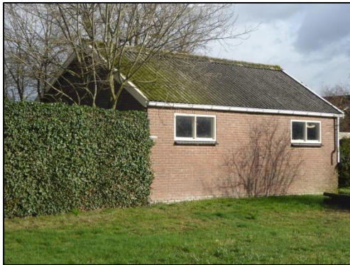
Te slopen schuur.
