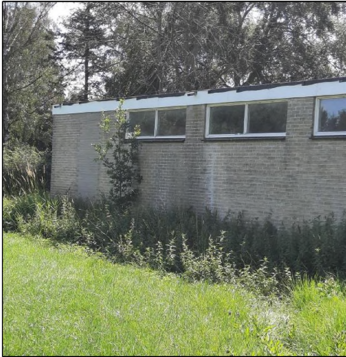
Figuur 11: Westelijke sloot afvoer schuur Hoornhorststraat 23
