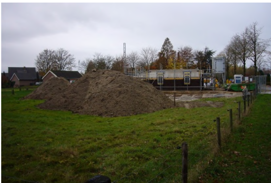
Opname van het westelijk deel, vanuit het zuiden.
