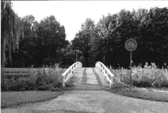
Foto's bestaande houten brug
