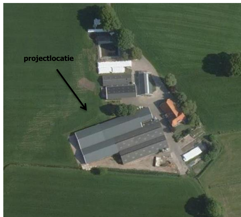
Figuur 2.3: Luchtfoto bedrijf met voorgenomen uitbreidingslocatie (Bron: www.ruimtelijkeplannen.nl)
