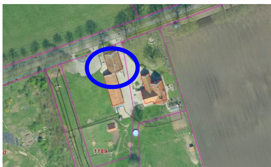
Te verbouwen bijgebouw Den Borgweg 12
