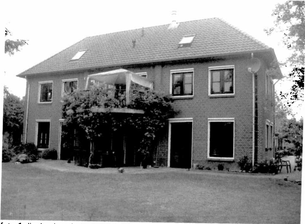
foto 1: ligging locatie (noordwestelijk gericht)
