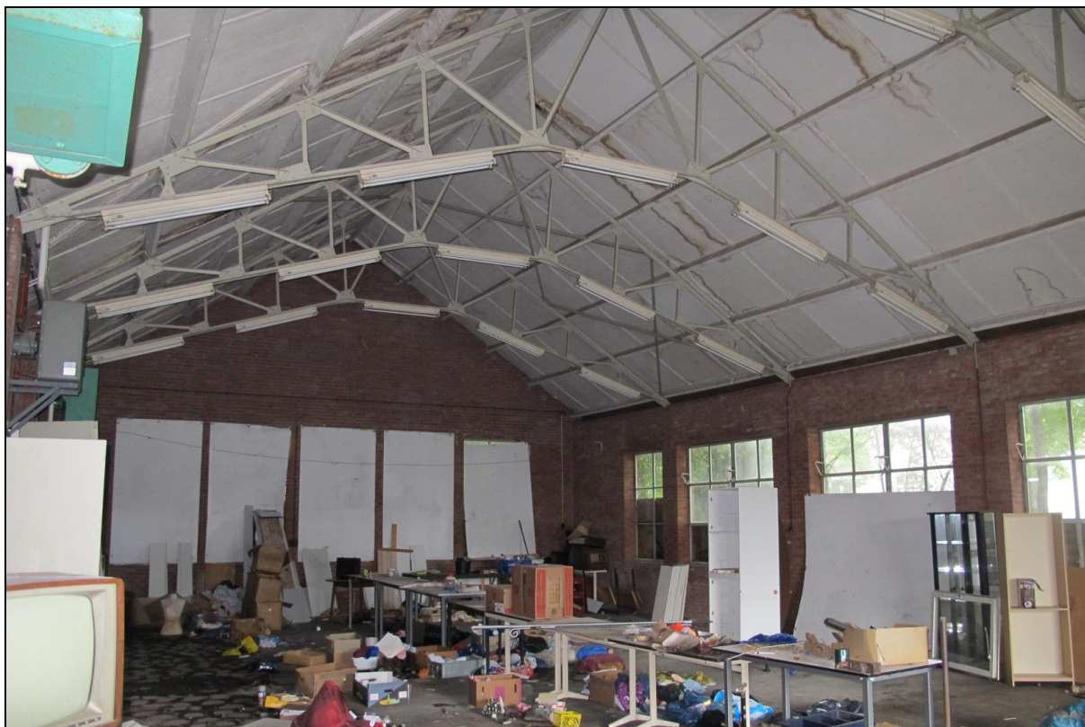
Voor landbouwwerktuigen bestemde zijvleugel met in het zicht gelaten ijzeren vakwerkspanten.
