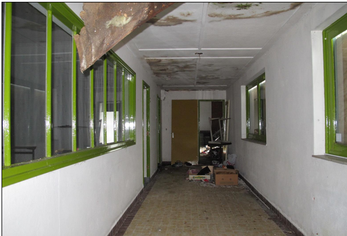
Langs de noordgevel gelegen gang met betegelde vloer.
