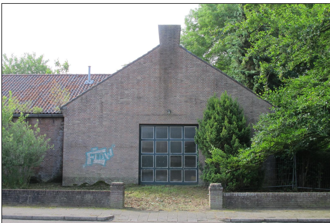
Voorzijde van de westelijke zijvleugel, met oorspronkelijke toegangsdeur voor werktuigen.
