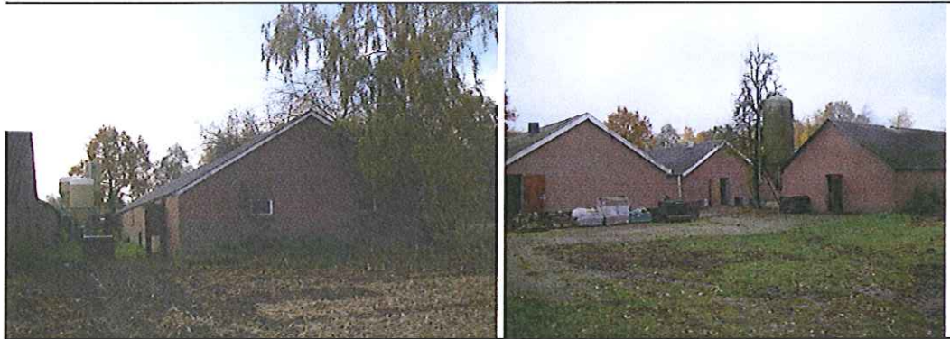
Foto's 1 en 2, Golfplaten op daken schuren
