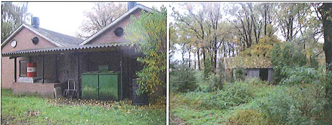
Foto's 3 en 4, Golfplaten op daken schuren
