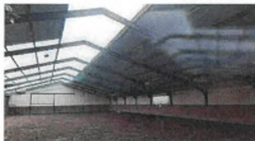
Fig. 1 voorbeelden van stal en rijhal waarbij daglicht naar binnen komt. In het donker straalt de verlichting dan van binnen naar buiten en werkt verstrend op de omgeving (rijhal in Juilste maat 45 x 26)
