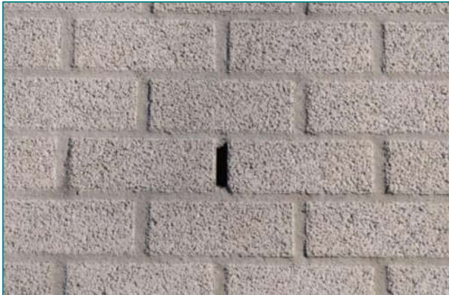
Figuur 6: Opengewerkte stootvoeg voor gewone dwergvleermuis. Enkele voegen worden breder opengewerkt tot ruim 2 centimeter soorten als mogelijke invliegopening voor laatvlieger.
