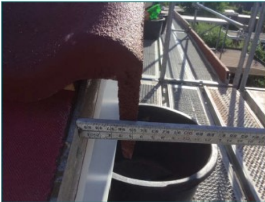
Figuur 4: afstand van 3 cm tussen boeibord en gevelpan. Hierdoor ontstaat een invliegopening en toegang tot de ruimte onder de dakpannen voor vleermuizen. Bovenste rand van het boeibord is opgeruwd.
