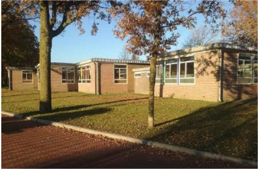
Voormalig schoolgebouw gezien vanaf de Heelweg bron: quickscan natuuronderzoek Ecochore
