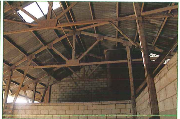
Te slopen kapschuur
