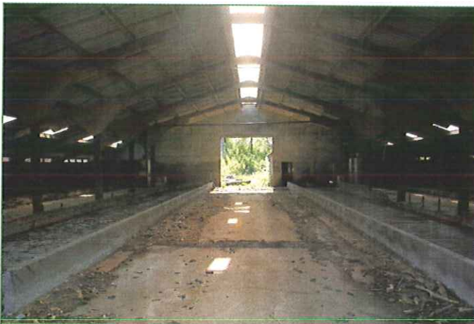
Te slopen koeien-loopstal
