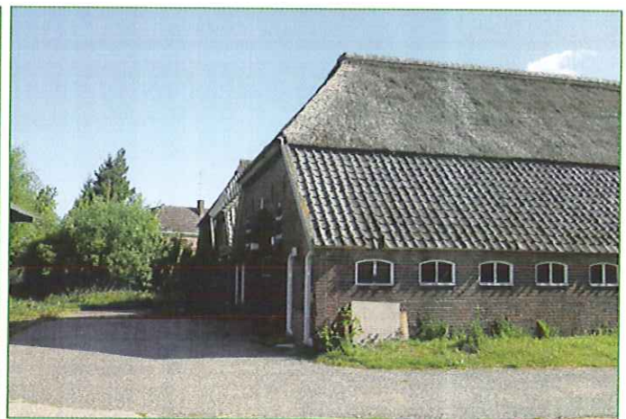
Achterzijde te behouden woning en deel. Zichtbaar is ook de nis van de Nen-deur. De schuur van het 'derde dak' zal ook worden gesloopt.
