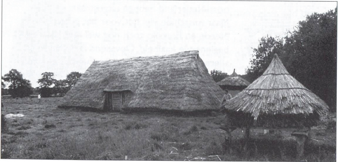
Afbeelding 6.: Zoals deze reconstructie in Orvelte laat zien bestond de prehistorische boerderij feitelijk uit een enorm dak, dat rustte op zware, in de bodem ingegraven palen. De buitenwanden waren erg laag en licht van constructie. Rechts een spiekertje, waarin graan kon worden opgegeslagen. 24
