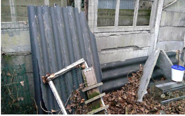
Foto's: Losliggende asbestvrije golfplaten (NT).
