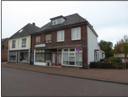
De gebouwen van de voorkant vanaf de Oudestraat;
