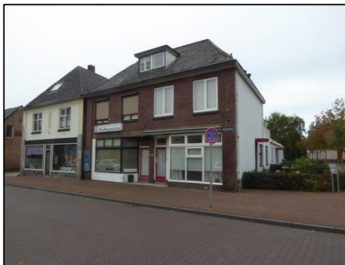
De gebouwen van de voorkant vanaf de Oudestraat;
