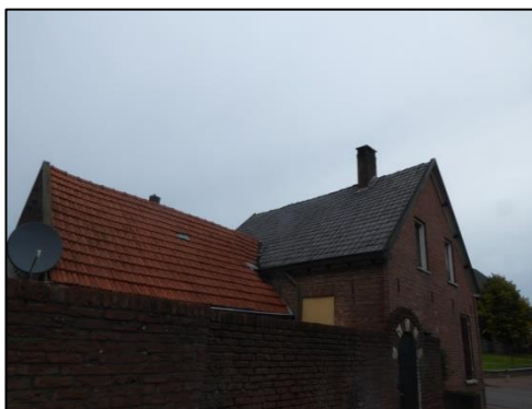
Achterzijde van de meest zuidelijke bebouwing;
