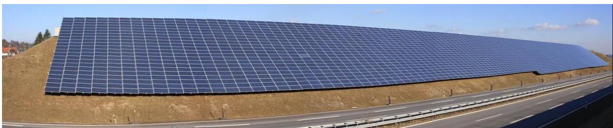
Afbeelding 22: Zonne installatie langs de a94 dicht bij Togg
