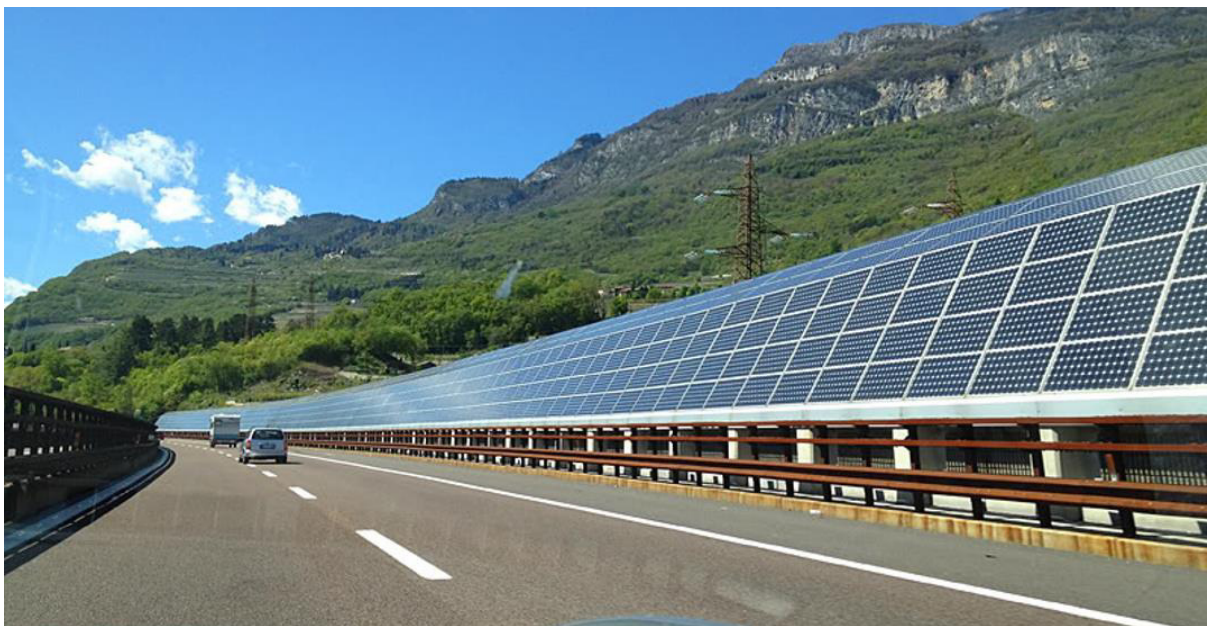
Afbeelding 21: Zonne installatie langs de "Brennerautobahn" in Italië
