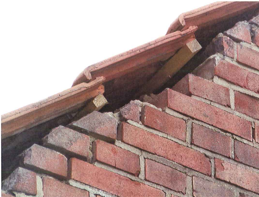
Figuur 3 toegang spouw onder pannen
