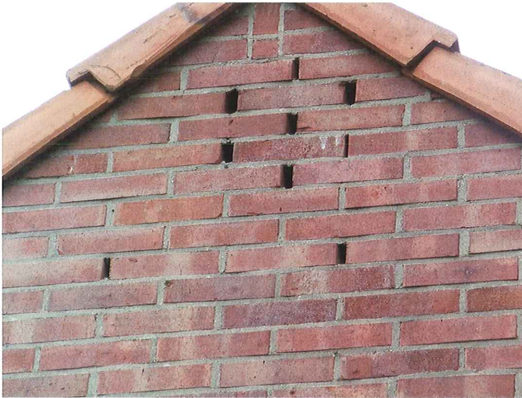
Figuur 5 ventilatiegaten spouw voorgevel
