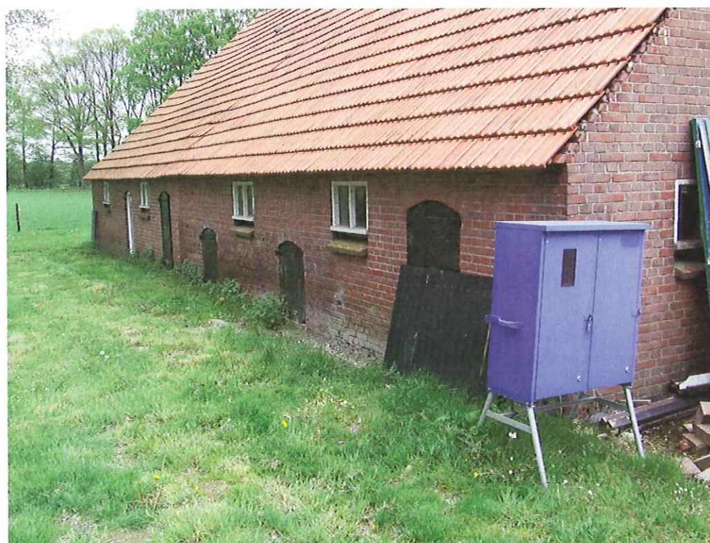
Figuur 2 linker- en achtergevel
