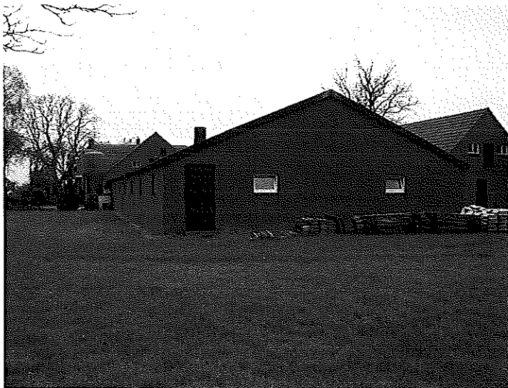
Gebouw E: varkensschuur. Het gedeelte dat tegen het erf aan ligt wordt gesloopt. Op de foto is de toekomstige voorgevel van de woning te zien.
