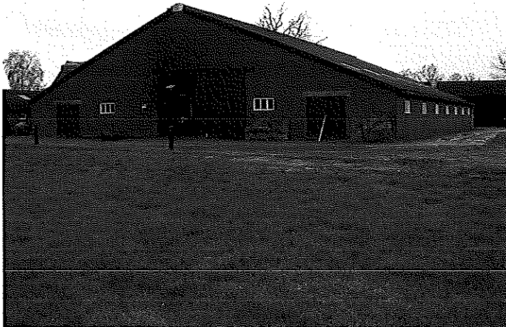
Gebouw G: ligboxenstal
