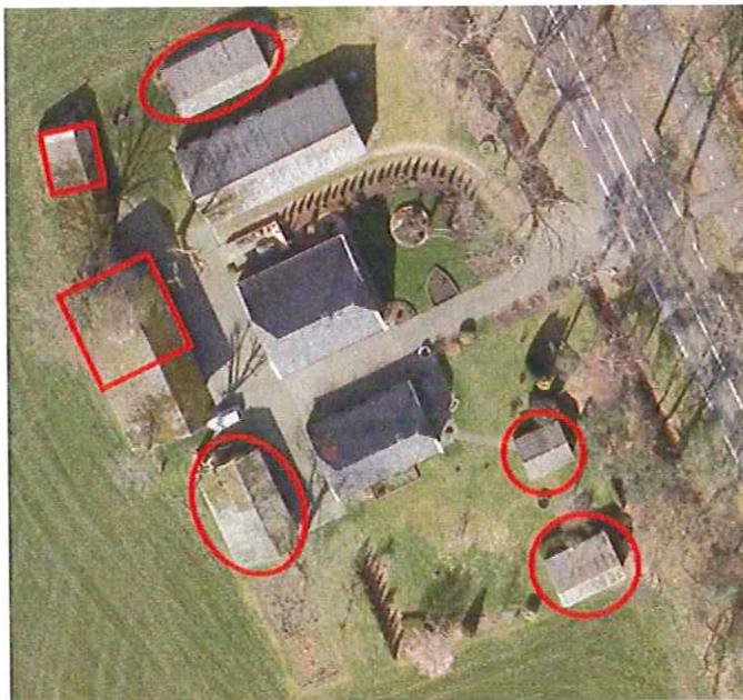
Figuur 3: De voormalige bedrijfsgebouwen die gesloopt gaan worden (rode cirkels geheel, rode vierkant gedeeltelijk).
